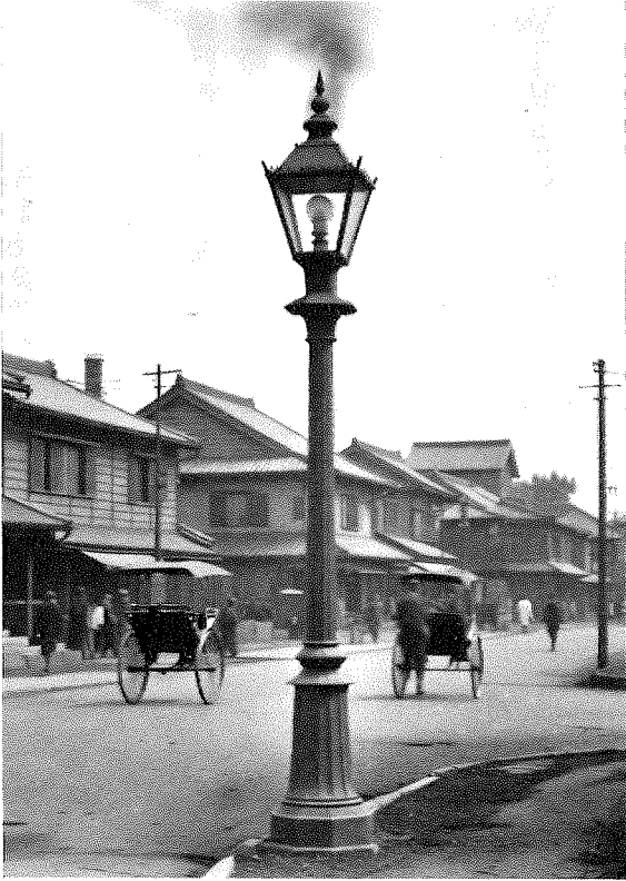
明治五年に設置されたガス灯
